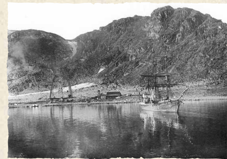
Camp Wellmann i Virgohamna under byggingen i 1906. Fra skipet Frithjof etablerte Wellmann forbindelse med omverdenen via trådløs telegraf - en sensasjon flere år før den første telegrafstasjon ble opprettet på Soalbard.
