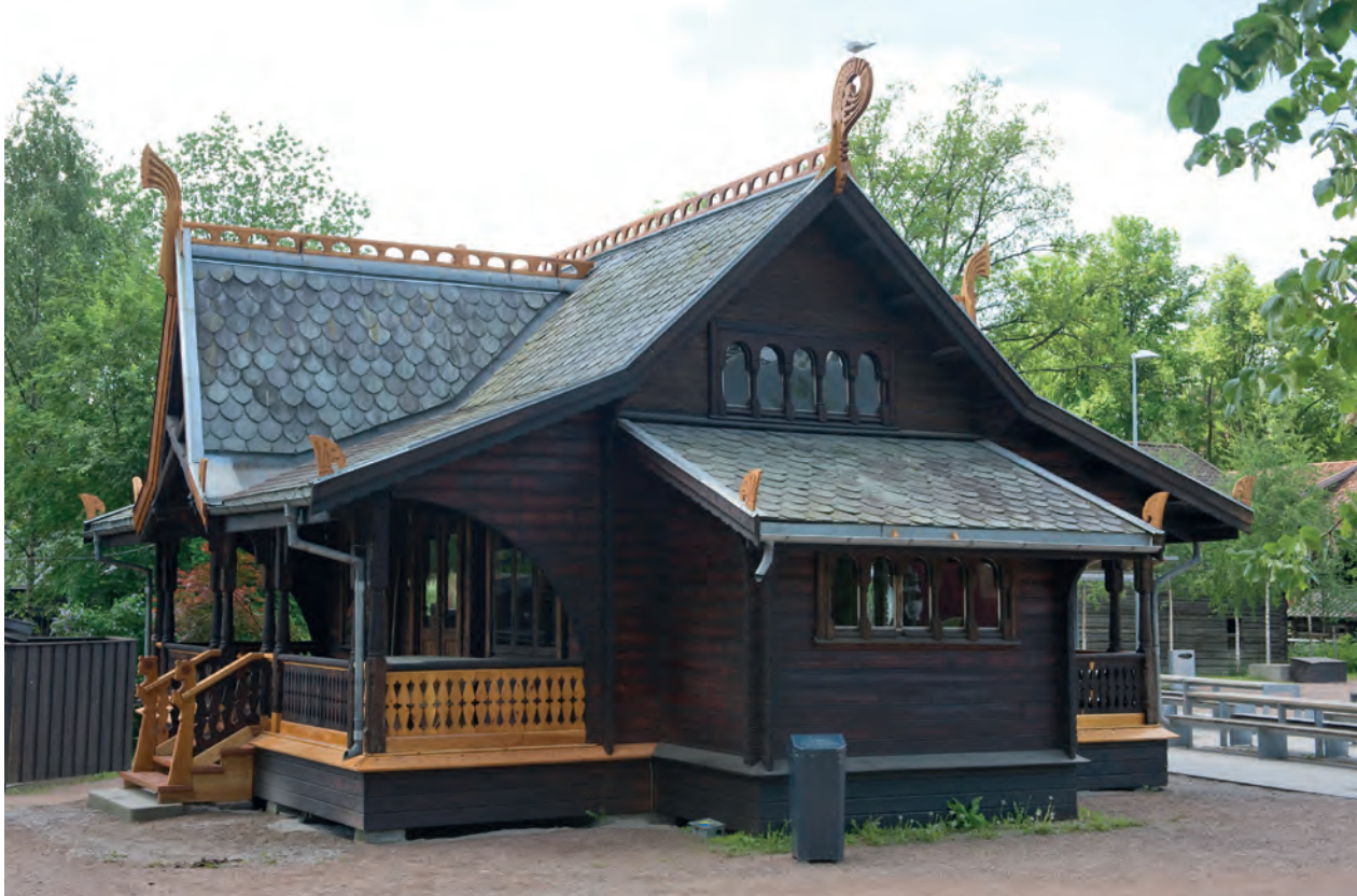
Ventehallens østfasade og gavl mot nord på Festplassen, Norsk Folkemuseum i juni 2010. Palmetter på taket og på vindski over utbygg samt svalgangens rekkverk er her reparert, men uendret i sin form fra 1896. De lyse partiene på bygningen viser nylig foretatt reparasjoner, som venter på den siste olje. Foto: Anne-Lise Reinsfelt, Norsk Folkemuseum NF.32974
