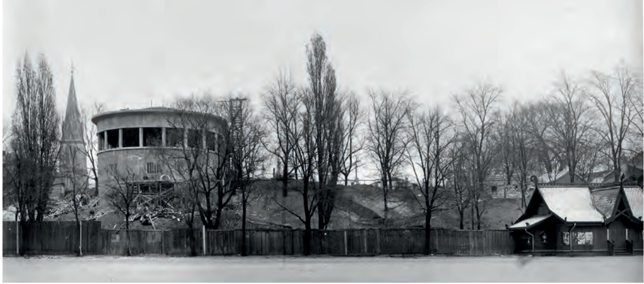
Restaurant «Skansen» under oppføring, vinteren 1926-1927 med Johanneskirken i bakgrunnen. Ventehallen til høyre i bildet, har fått plater for vinduer, svalgang og dører, benkene er også borte. Bygningens funksjon som ventehall og kafé var snart over. Foto: O. Væring, Arbeiderbevegelsens arkiv og bibliotek AAB.0033324
