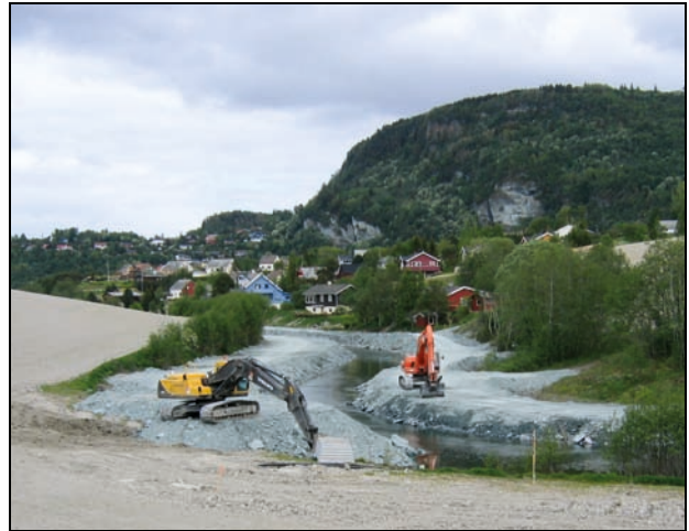
Figur 8.4 Motfylling og erosjonssikring for å hindre kvikkleireskred. Vigda, Skaun.
