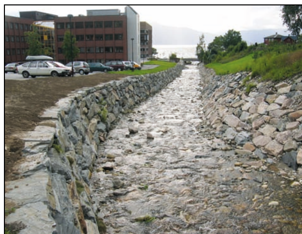
Figur 8.2 Sikring med stein for å hindre erosjon/utgraving i elveløpet. Njøsaelvi, Leikanger.
