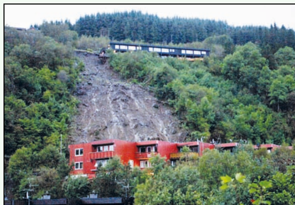
Figur 3.11 Jordskred ved Hatlestad terrasse i Bergen 2005
