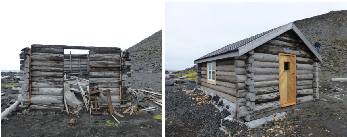
Badstuen i 2013 før restaurering og etter restaurering i 2016
