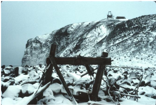
Taubaneenden på Bommen og skinnegangen til hovedhuset i 1985
