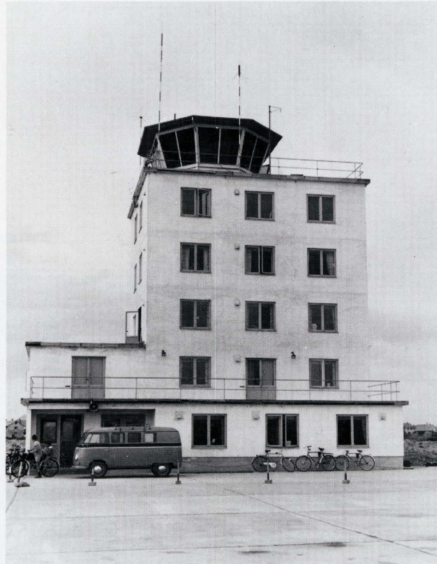
Det første terminal- /sikringsbygg. (1952)
