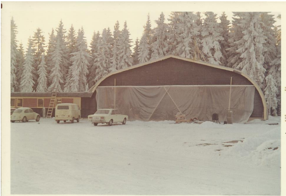
Ny hangar på Stafsberg under bygging
