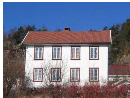
Arbeiderbolig ved Berger fabrikker i Svelvik kommune. Foto: Niku.
