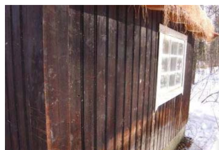
Panel og vindu, hønsehus. Foto: NIKU.
