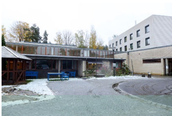
Høyås bo- og rehabiliteringssenter, Nordre Follo kommune. Foto: Sivilombudet
