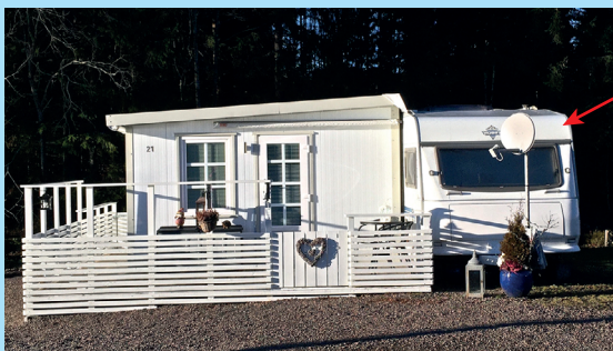
Figur 1.3 Her ser vi et såkalt spikertelt. Selve campingvognen (rød pil) er utvilsomt løsøre, da den har hjul og enkelt kan flyttes. Men vi ser at det er bygget faste konstruksjoner som påbygg til campingvognen som ikke lett kan flyttes. Her står vi trolig overfor et grensetilfelle. Foto: Einar Mo.
