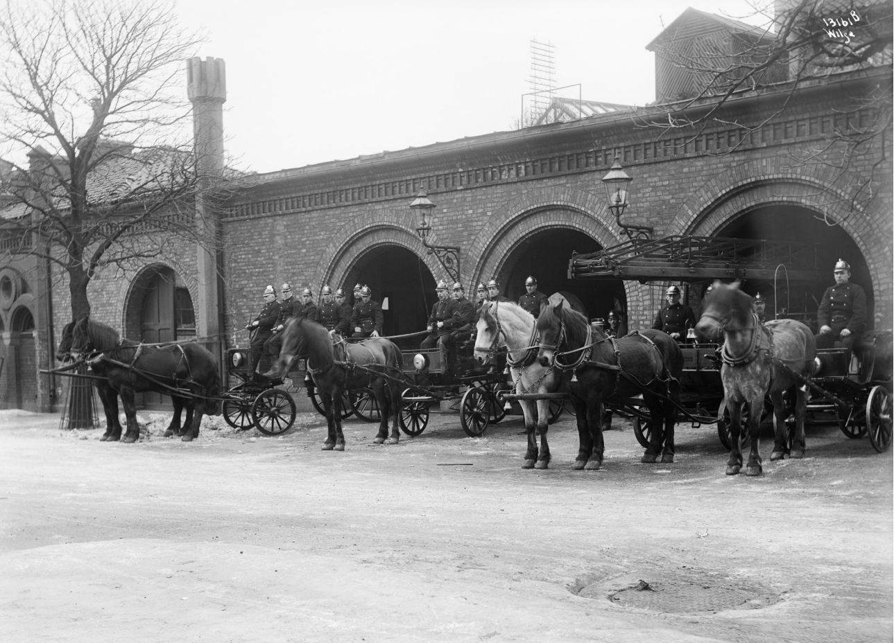
Brannvakten, Karl Johans gate 11 ved Oslo domkirke ca. 1905. Foto: Anders Beer Wilse / Oslo Museum.
